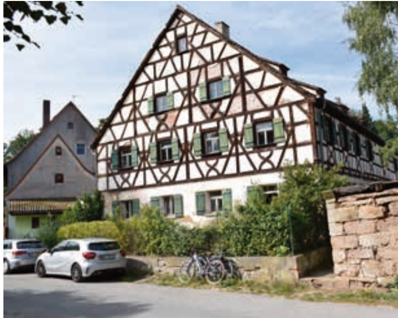
Das Haus in Wendsdorf soll wieder ein Schmuckstück werden
