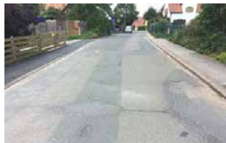
Altzustand der Ortsdurchfahrt Fernabrünst
