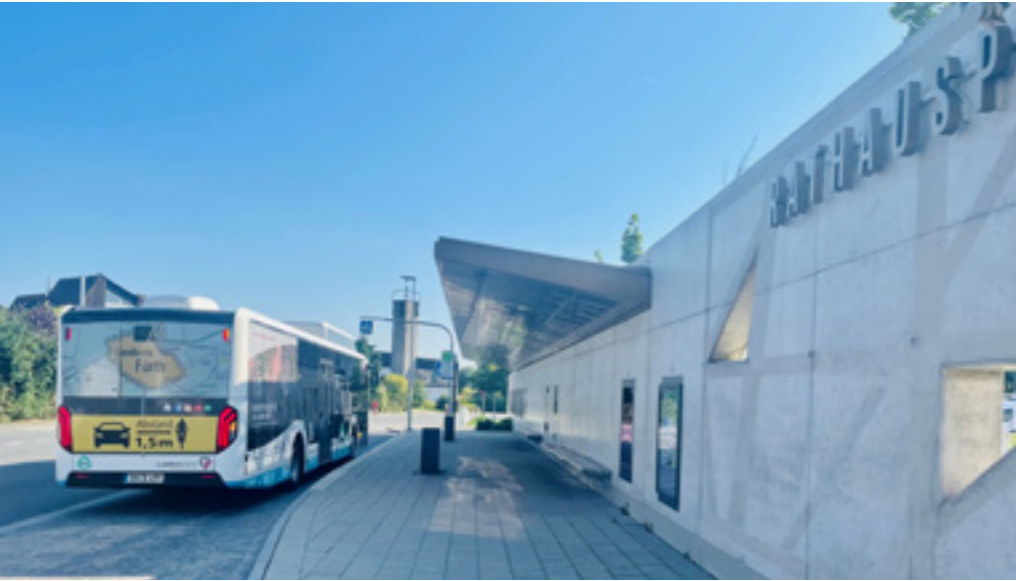
Die umgestaltete Bushaltestelle in Oberasbach am Rathaus
