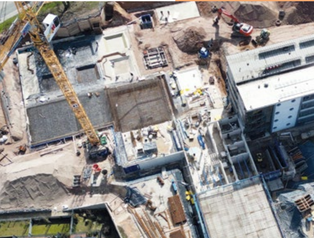
Aktuelle Baustelle Landratsamt
